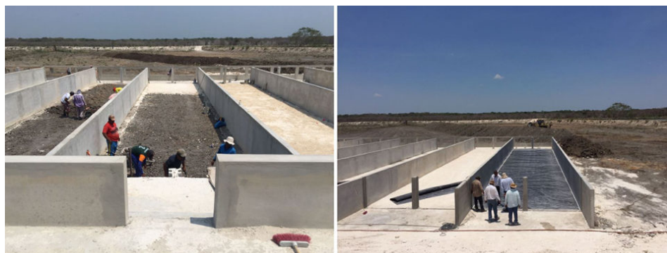
Vista de la construcción de raceways para el proyecto de demostración.
